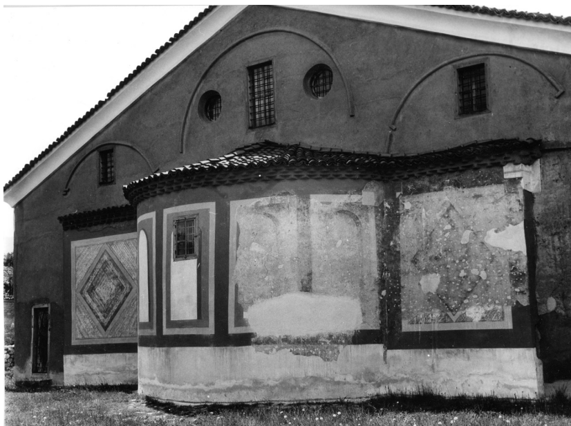
Приложение № 7. Източната стена на Митрополитската църква в Самоков, преди и след реставрацията
