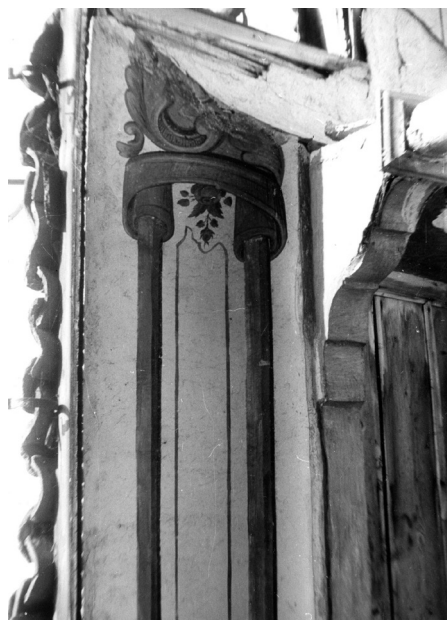
Приложение № 16. Елементи от фасадата на Максимовата къща в Самоков (несъществуваща днес)
